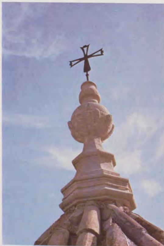
Boya y cruz de remate de la linterna ya restaurada.
