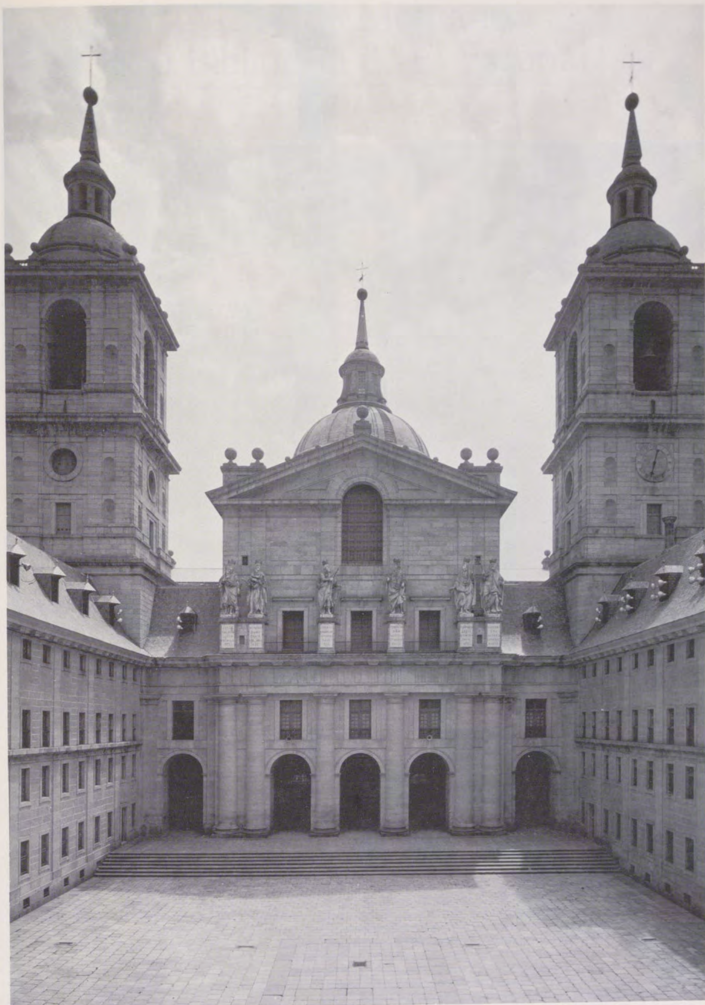
Pórtico de la Basilica sobre el que descansan las seis estatuas de los Reyes del Antiguo Testamento. Patio de los Reyes del Real Monasterio de El Escorial.
