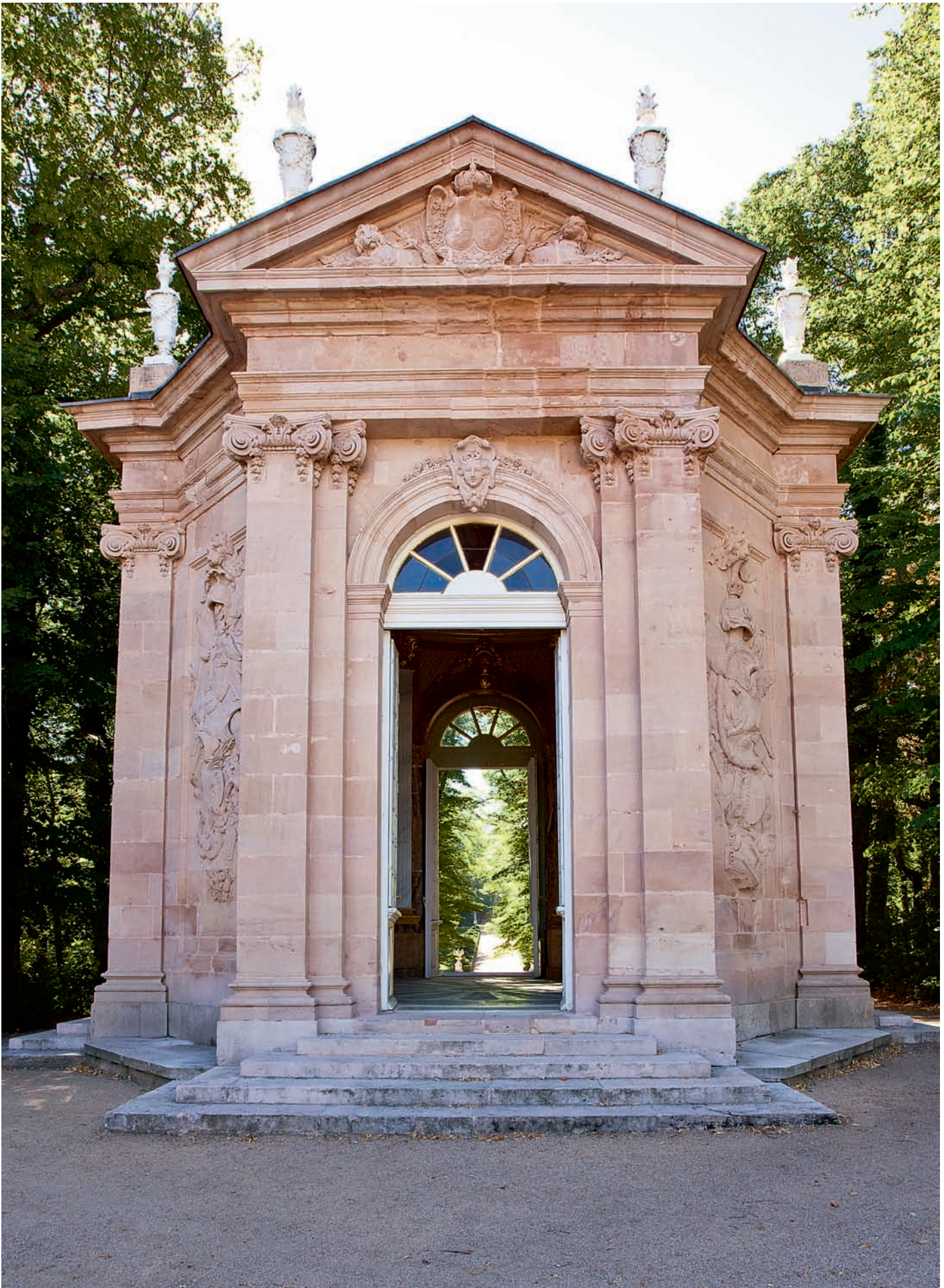
Fig. 4. Fachada frente a la fuente de las Tres Gracias.
