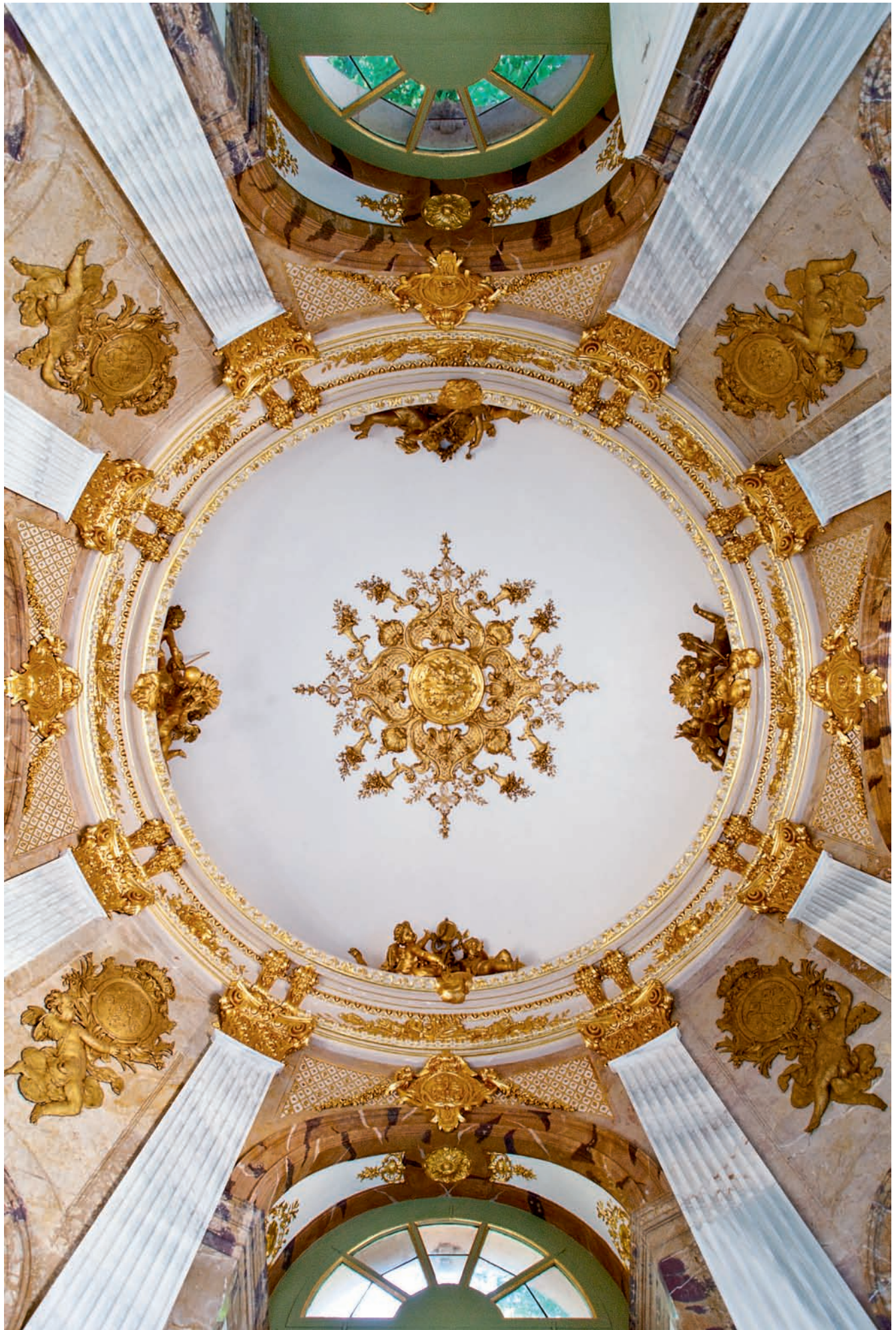
Fig. 13. Vista de la bóveda desde el pavimento, con la disposición de las alegorías en el interior.
