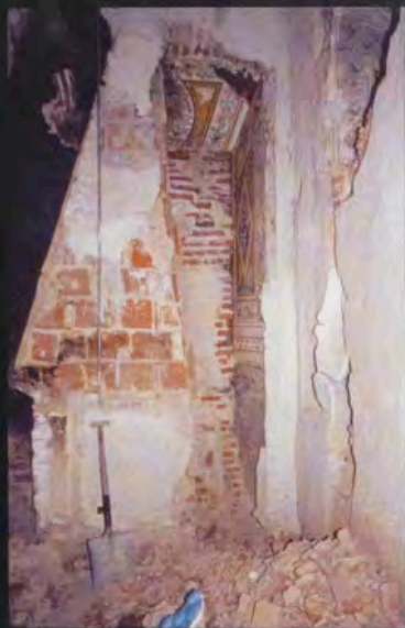
Descubrimiento del hueco del balcón oriental y pinturas
