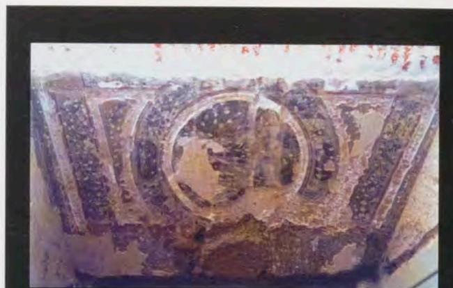
Eliminación de la capa de yeso.
