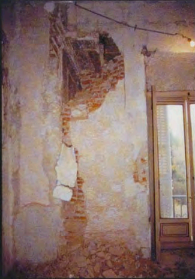
Descubrimiento del hueco del balcón meridional y pinturas.
