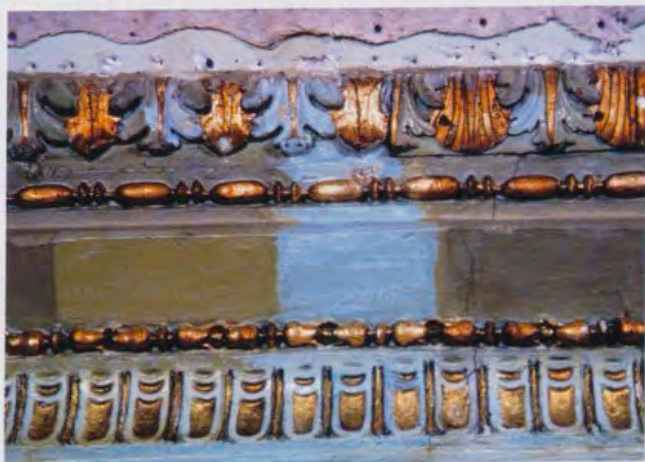
Capas de limpieza: Eliminación de repintes en la cornisa.
