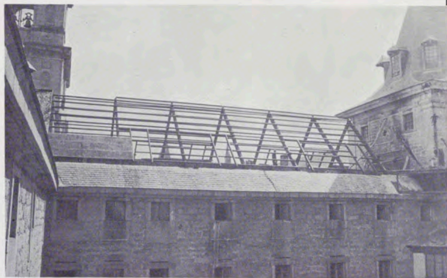
Tres vistas de la parte afectada durante el incendio declarado en el Monasterio de El Escorial. En orden inverso, se aprecian: la fase de colocación de las planchas de pizarra sobre la cubierta de la buhardilla, la operación para colocar la estructura metálica y un aspecto de la zona siniestrada al día siguiente del suceso.
