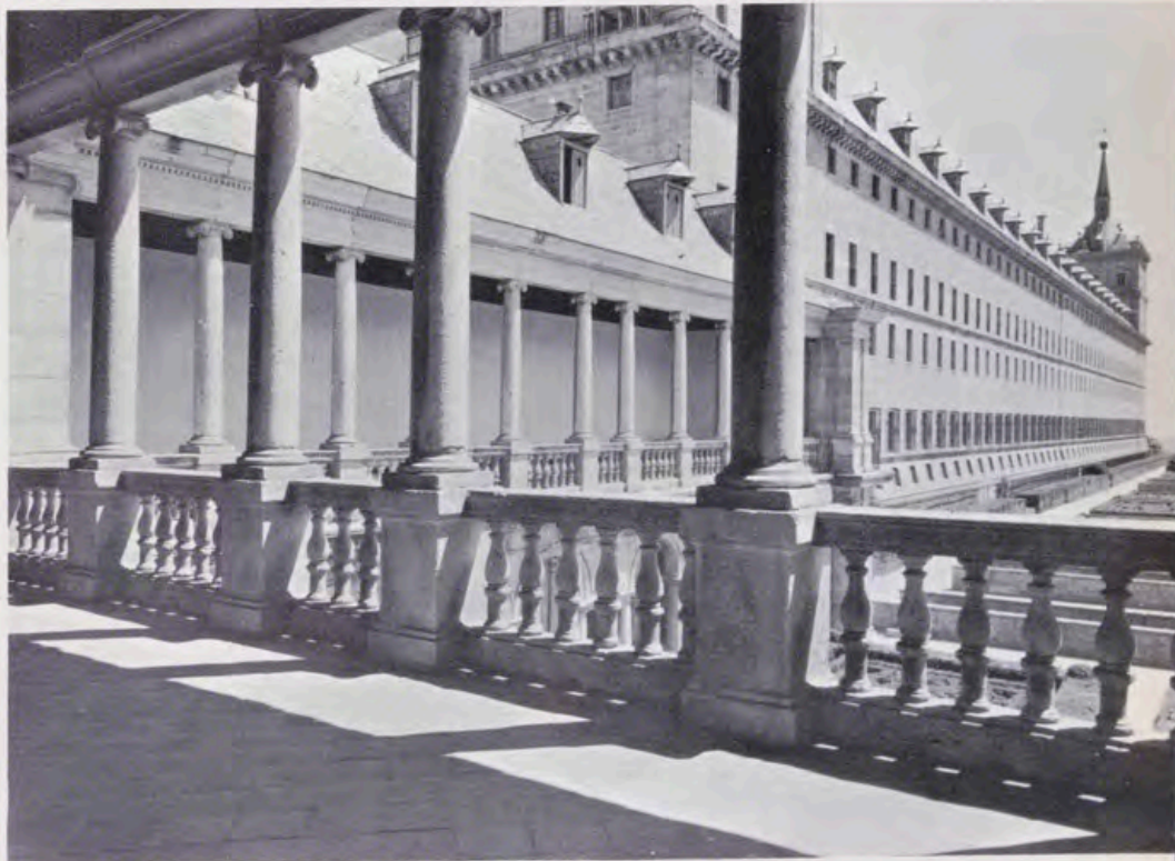
Fachada del mediodía y Jardín de los Frailes del Monasterio de El Escorial desde la planta noble de la Galería de Convalecientes.
