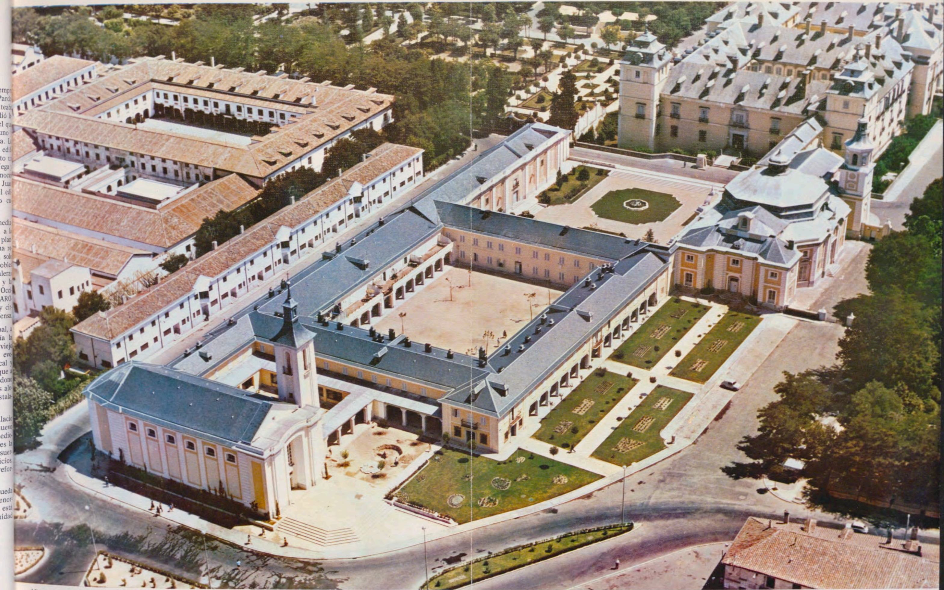
Vista general de la urbanización efectuada en El Pardo.
