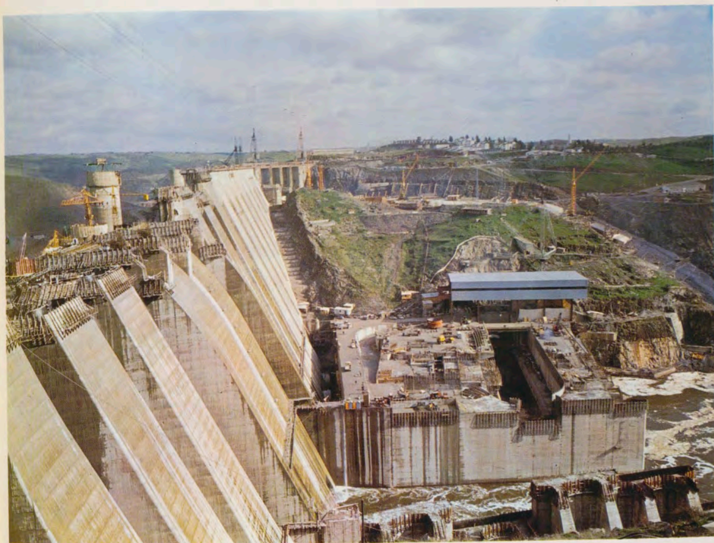
Obras en el Salto de Alcántara
