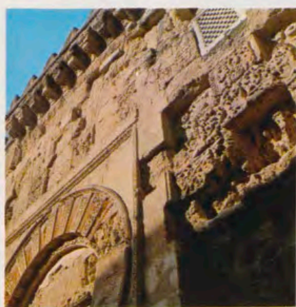
Mezquita-Aljama: muro de poniente.
