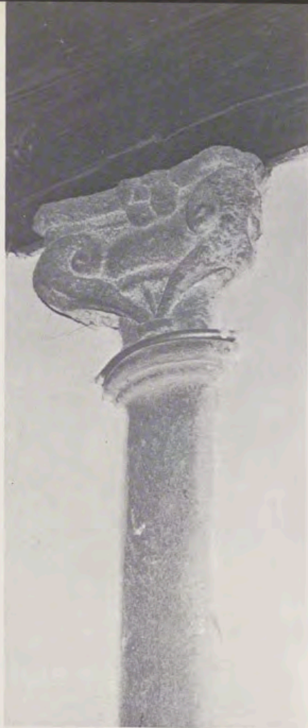
Galería del patio, al estilo castellano del siglo XVI, que se transformó para convertirse en la Casita de Nazaret. En las dos fotos se aprecian los capiteles y las zapatas de madera empotrados en el muro.
