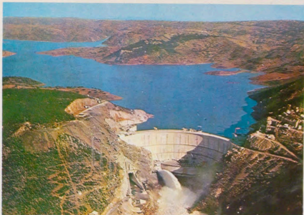
Salto de Valdecañas sobre el río Tajo. Potencia total instalada 225.000 KW. Energía regulada 750.000 KW año.
