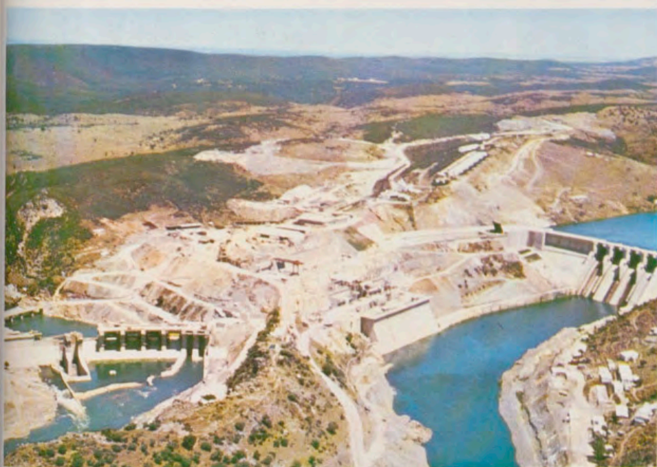
Salto de Torrejón sobre los ríos Tiétar y Tajo. Potencia total instalada 132.000 KW. Producción media anual: 450 millones de KW.
