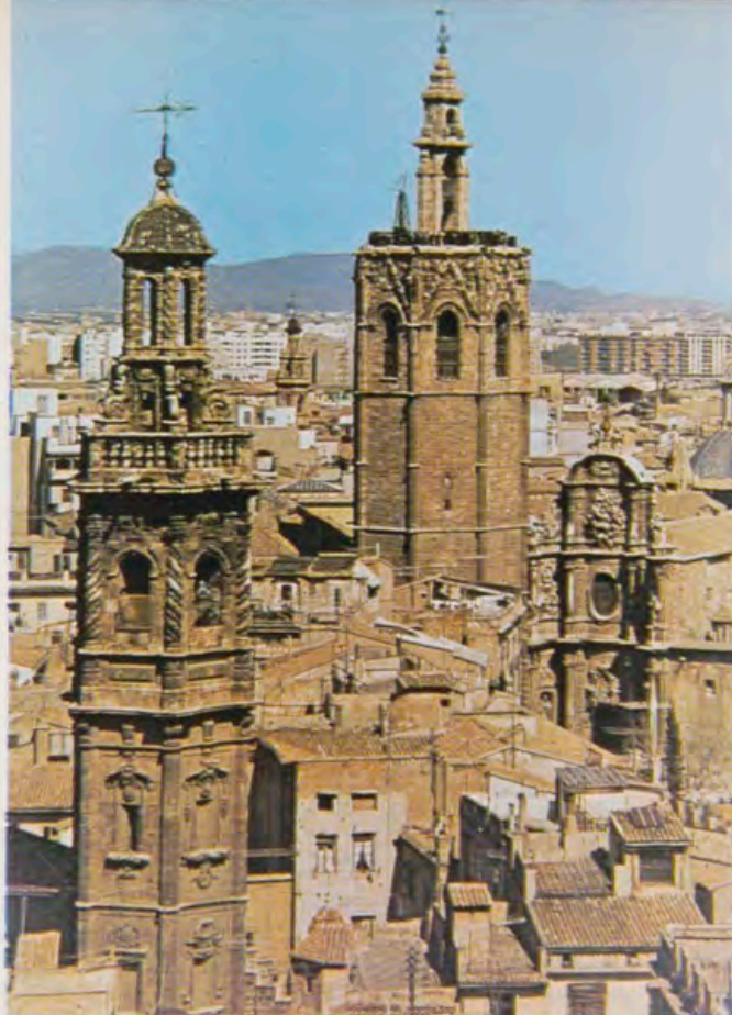
Torre de Santa Catalina y el «Miguelete».
