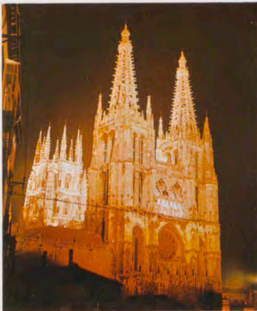
La Catedral iluminada.
