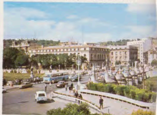
Vista con el puente de San Pablo.
