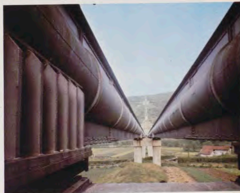
Paso sobre el río Cadagua.
