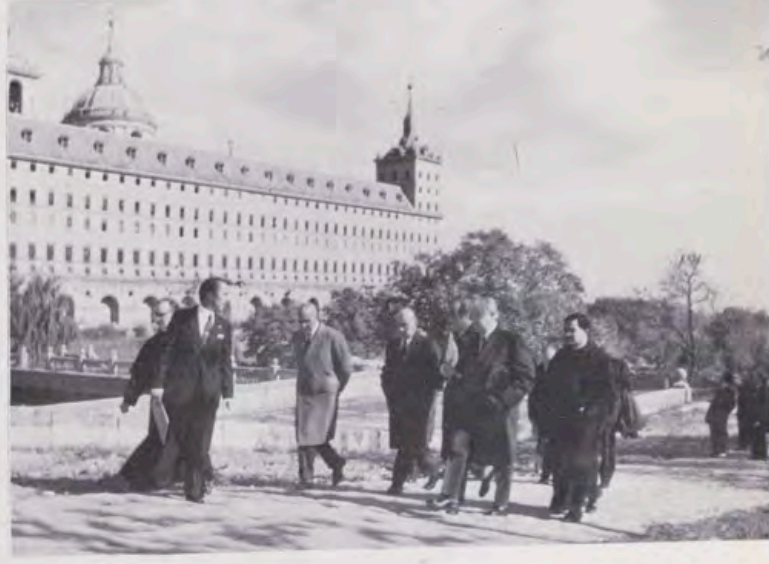
Los componentes del Consejo del Patrimonio visitan las recientes obras de El Escorial.
