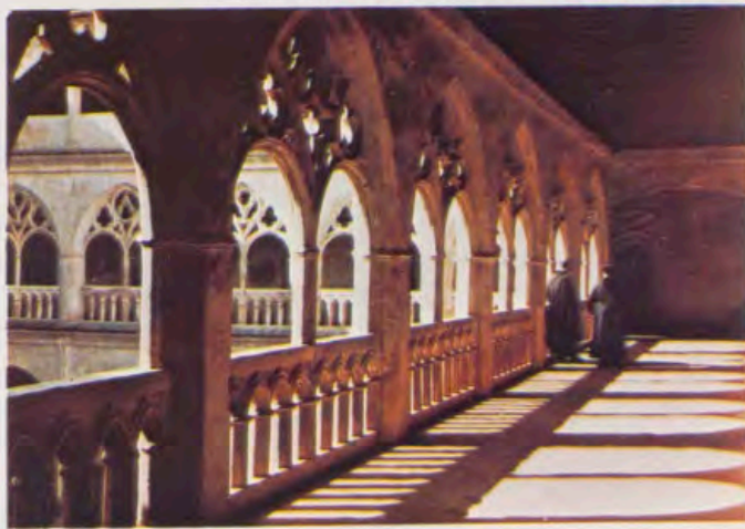
Galería central del claustro de la botica (siglo XVI).
