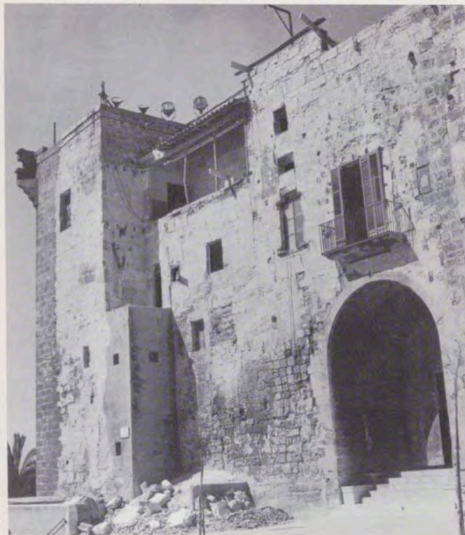
Palacio de la Almudaina. Fachada principal antes y después de su restauración.
