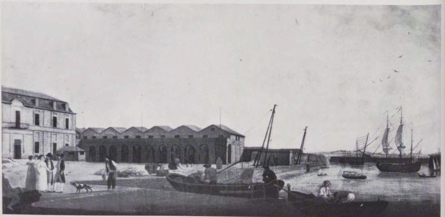
La Coruña: arsenal de El Ferrol.
