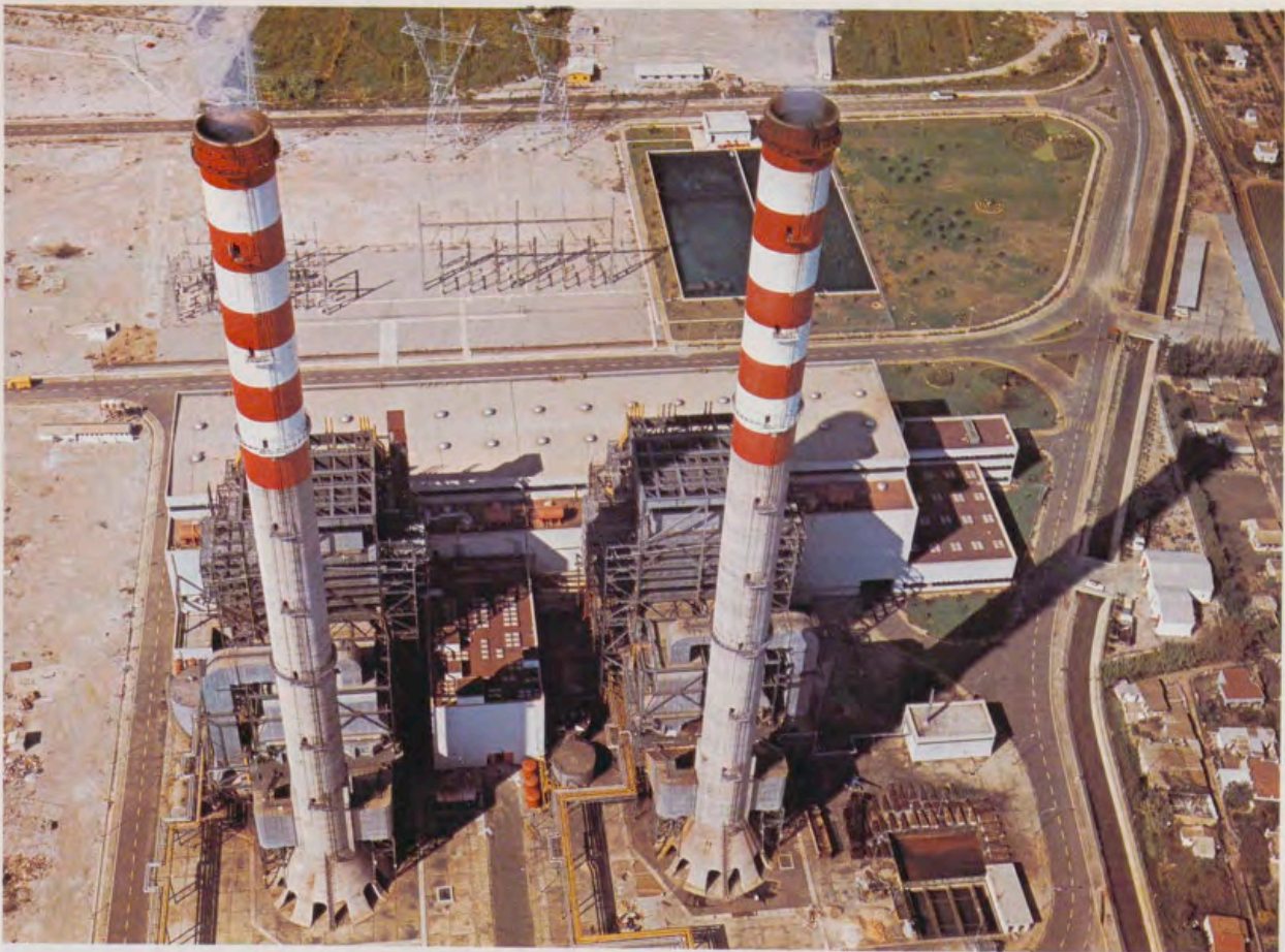
CENTRAL TÉRMICA DE CASTELLÓN
