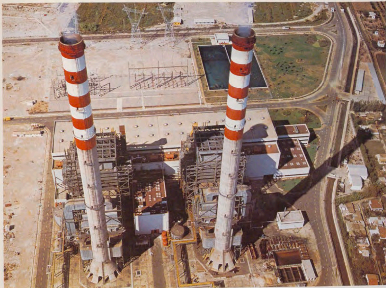
CENTRAL TÉRMICA DE CASTELLÓN
