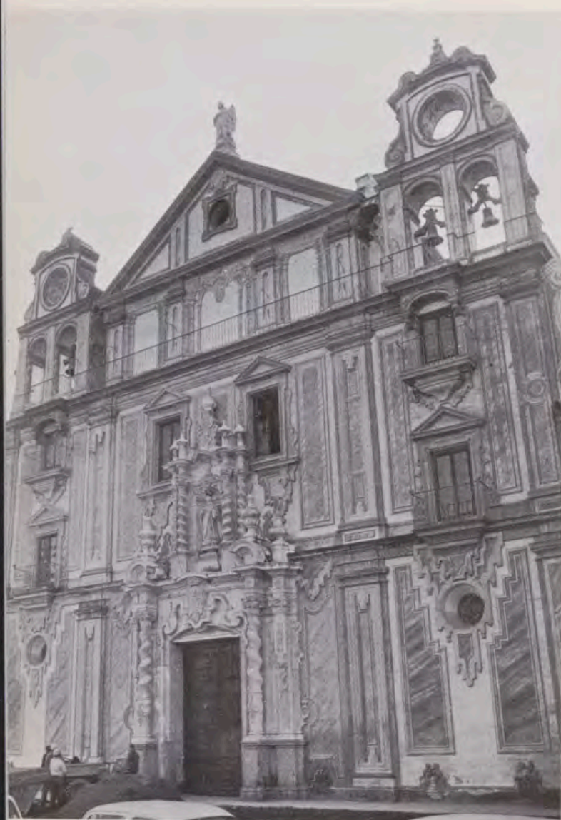
Fachada de la iglesia de La Merced.
