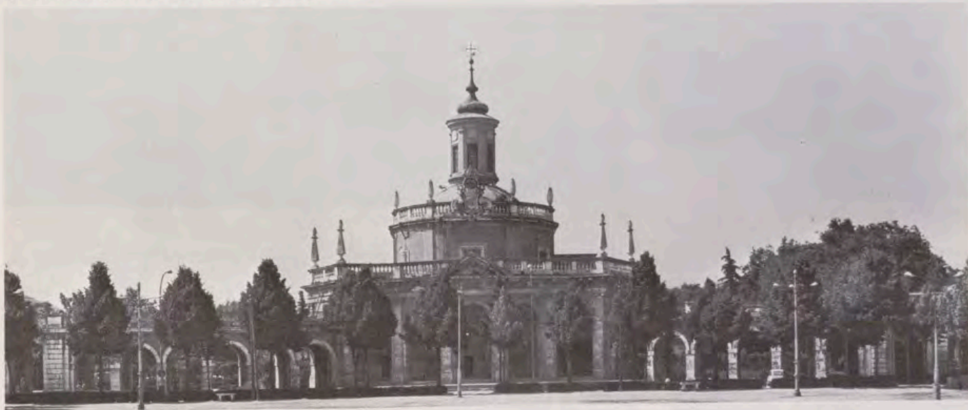
Exterior de la iglesia de San Antonio, en la actualidad.
