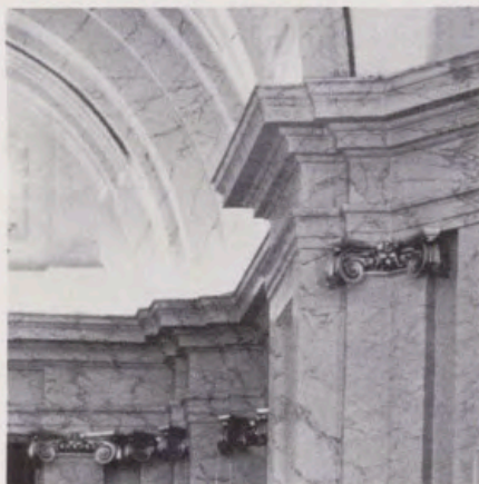
Interior de la Capilla: detalle del entablamento.
