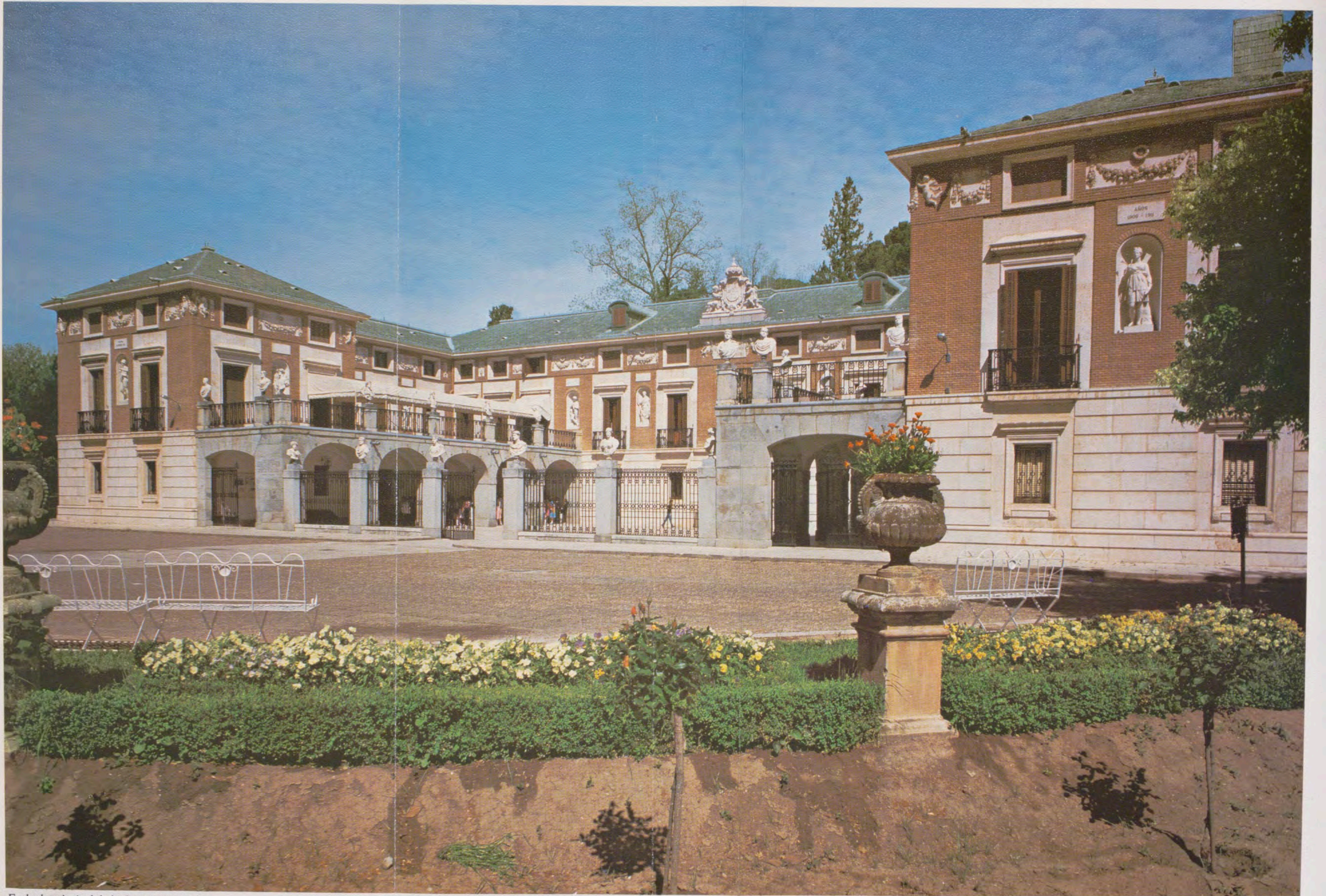
Fachada principal de la Casa del Labrador con el jardín en primer término (Real Sitio de Aranjuez).
