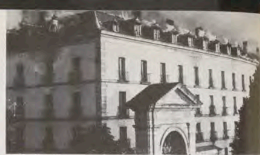
Incendio de la cubierta de la Casa de Infantes, en La Granja.
