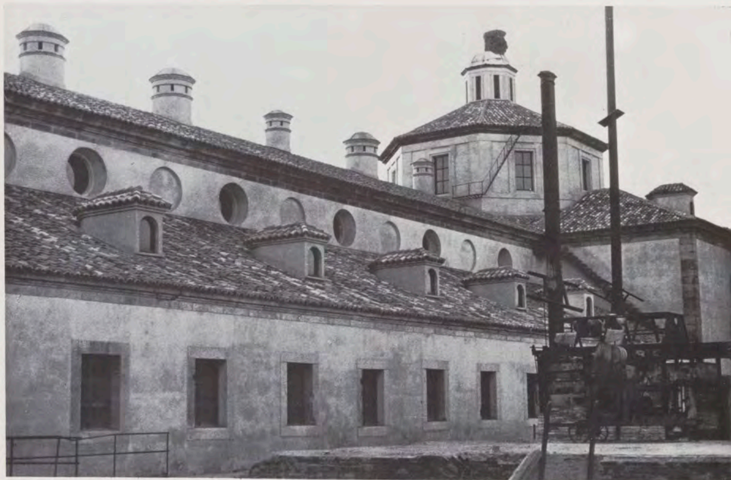
Fachada interior de la crujía sur de la Real Fábrica de Cristales de La Granja.
