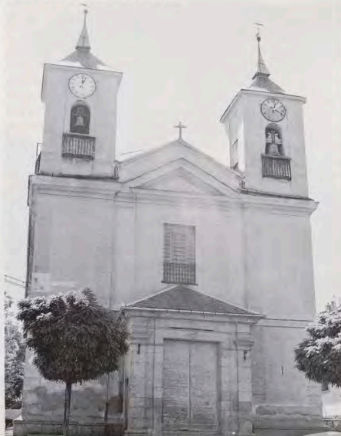
Iglesia de los Dolores. Fachada principal.
