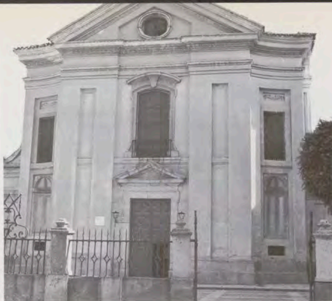
Iglesia del Cristo. Fachada principal.
