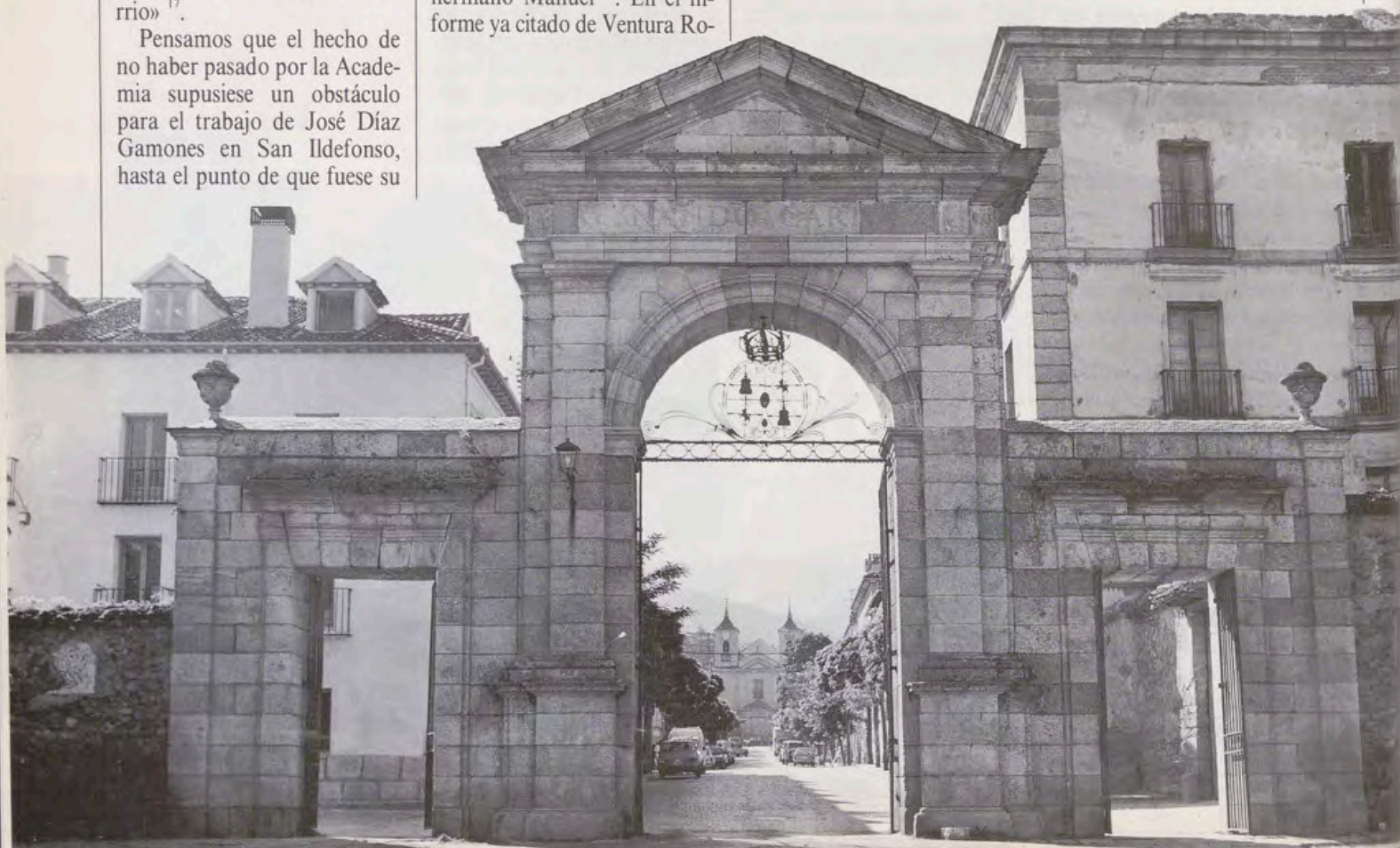
Puerta de Piedra o de la Reina. Al fondo la Iglesia de los Dolores.
