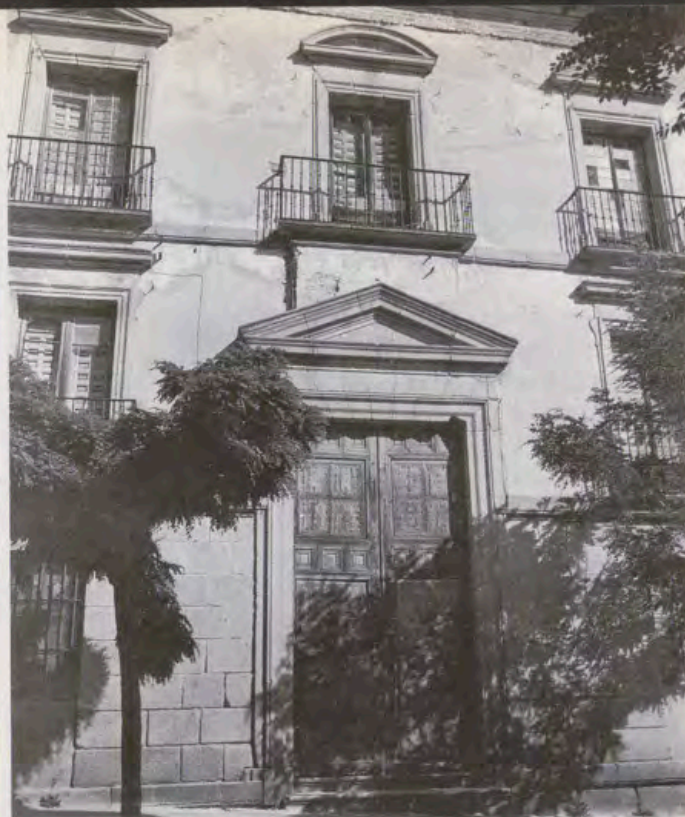
Casa de Infantes. Detalle de la fachada principal.
