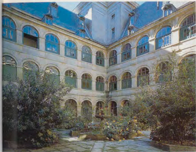
Exterior de uno de los Claustros Chicos del Convento.
