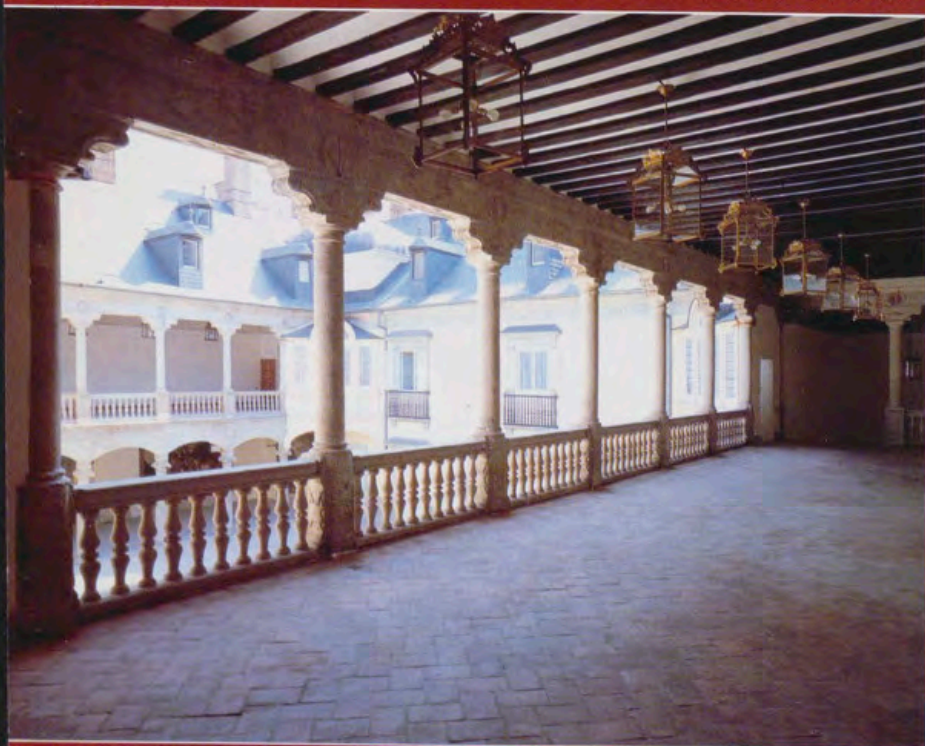
Galería alta en el Patio de los Austrias. Palacio Real de El Pardo.
