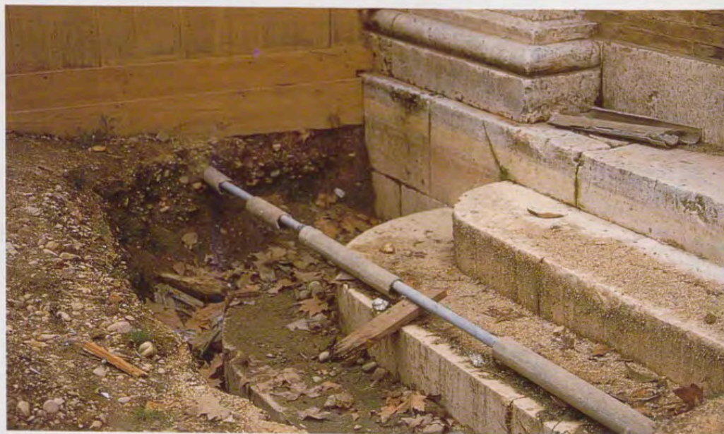
Aspecto de las obras de 1983 efectuadas en el Jardín del Rey.
