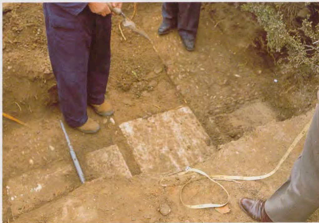
Jardín del Rey: obras de empedrado realizadas en 1983.
