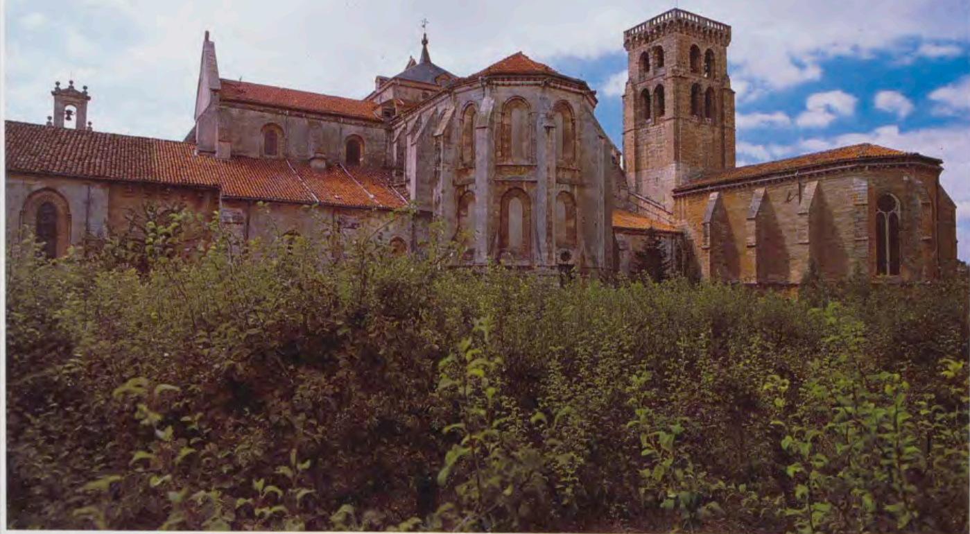
Vista general de la cabecera de la iglesia.
