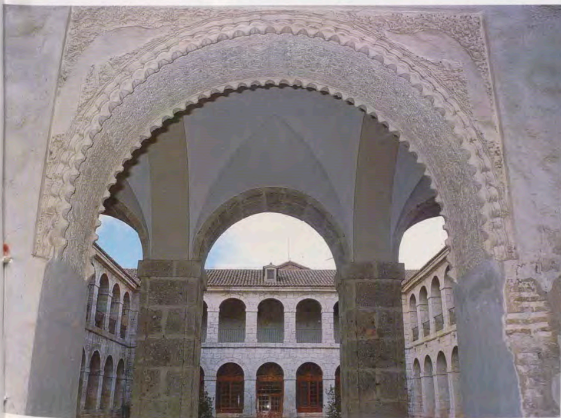
Arco mudéjar que daba acceso al salón, luego utilizado como Iglesia provisional o «Coro largo».
