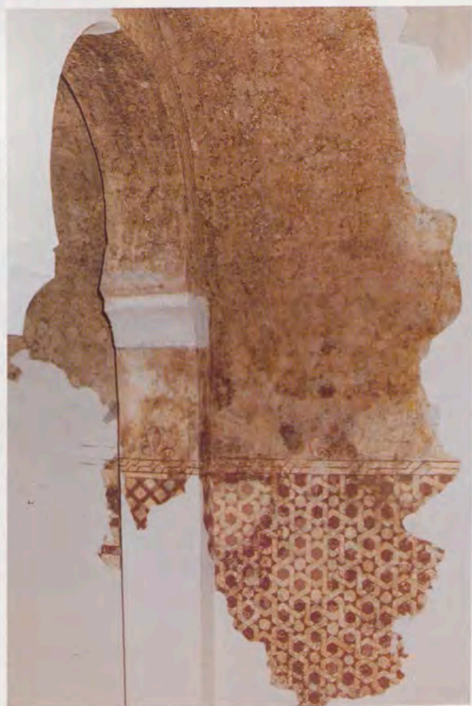
Dentro de la decoración original, consolidada, las lagunas han sido rellenas con rigatino.
