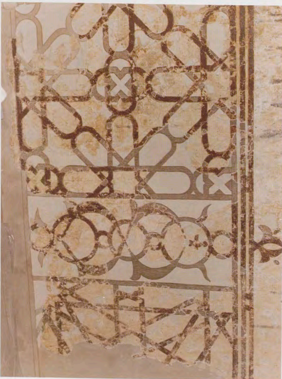
Restauración de 1990 en el Cuarto Templado.
