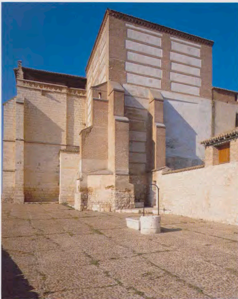
Exterior de la cabecera de la Iglesia. Santa Clara de Tordesillas.
