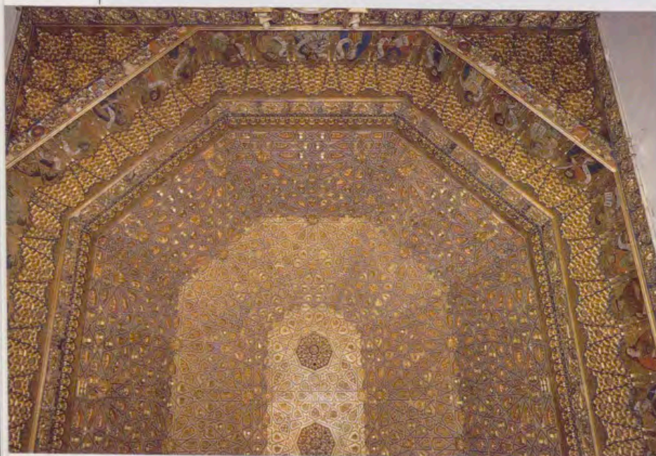
Estructura ochavada de la armadura de Santa Clara de Tordesillas, y detalle de uno de los mocárabes y decoración flamígera en los miembros o polígonos de la techumbre.
