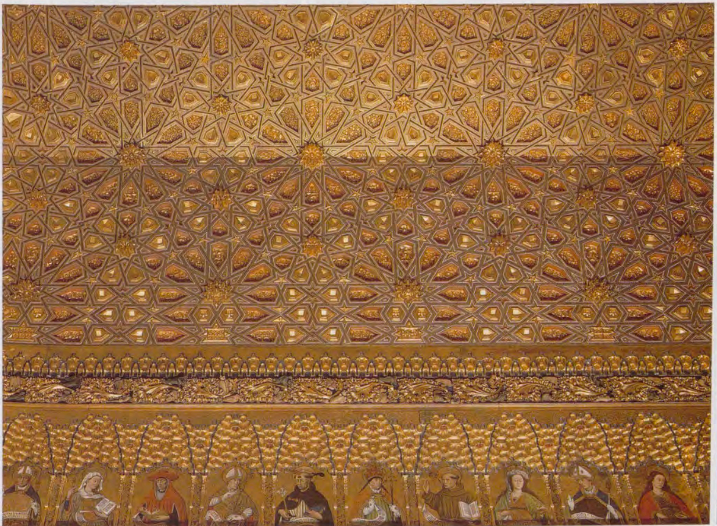
Uno de los faldones mayores de la techumbre de Santa Clara. Quiebro en dos planos distintos de los paños.
