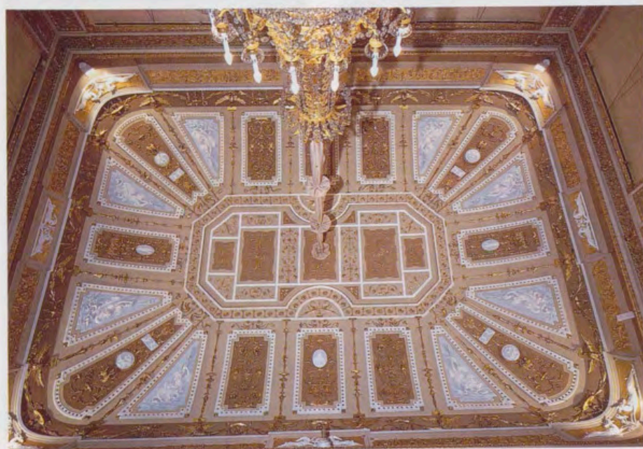
Detalle del techo del Despacho de S.M. el Rey durante el proceso de restauración, y techo de este mismo despacho una vez restaurado.
