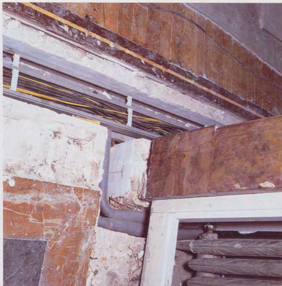
Detalle de las obras para disponer las instalaciones eléctricas, telefónicas y de calefacción. Acometida a un radiador.
