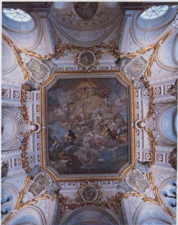
Aspecto general de la bóveda. Estado final.
