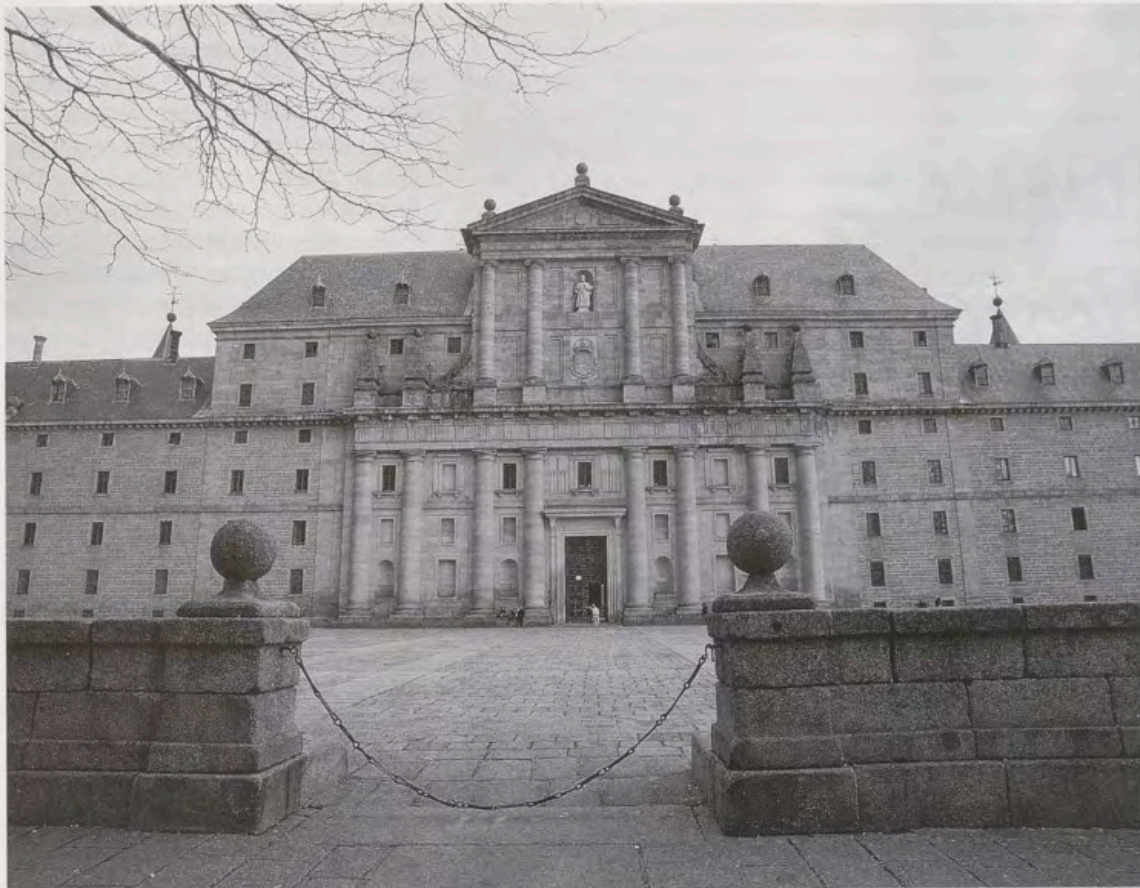
Fachada poniente del Real Monasterio de El Escorial.
