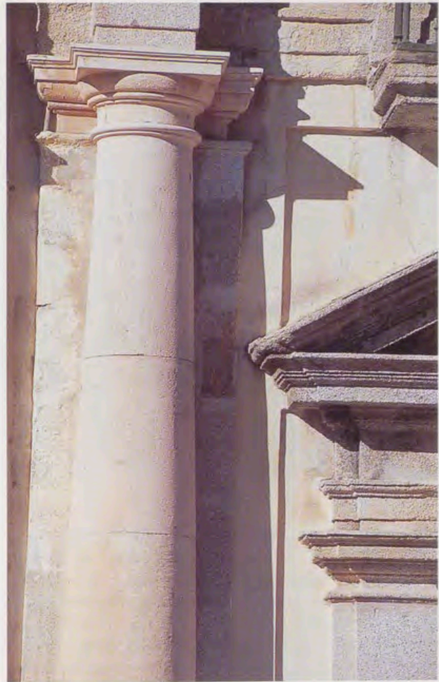
Andrea Procaccini, Detalle de la fachada a los Jardines del Palacio de La Granja. Fotografía: David Gómez Lozano.
