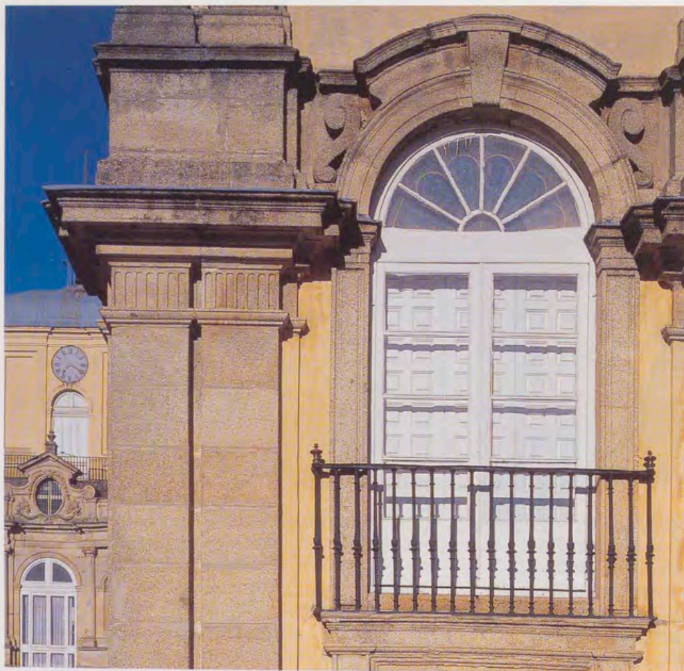
Andrea Procaccini, Detalle de la fachada al Parterre de La Fama de una de las alas del Patio de la Herradura.
