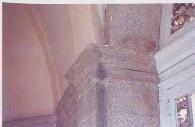
Andrea Procaccini, Detalle de una pilastra, con capitel oblicuo plegado a la curva convexa de la parte trasera de la exedra del Patio de la Herradura.
