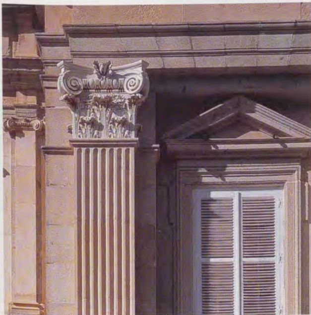
Detalle del encuentro entre las fachadas de Procaccini y Juarra-Sacchetti.
