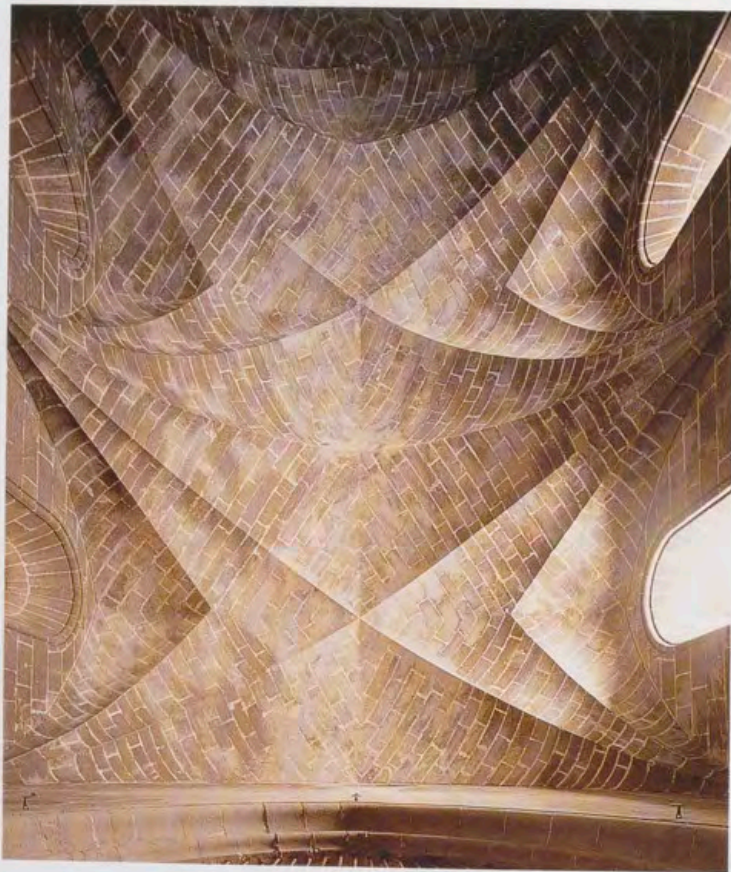
Bóvedas de la Capilla de los Reyes, Cuartel General de la Fuerza de Maniobra - Antiguo Real Convento de Predicadores de Santo Domingo, Valencia, Fotografía: Paco Alcántara.
