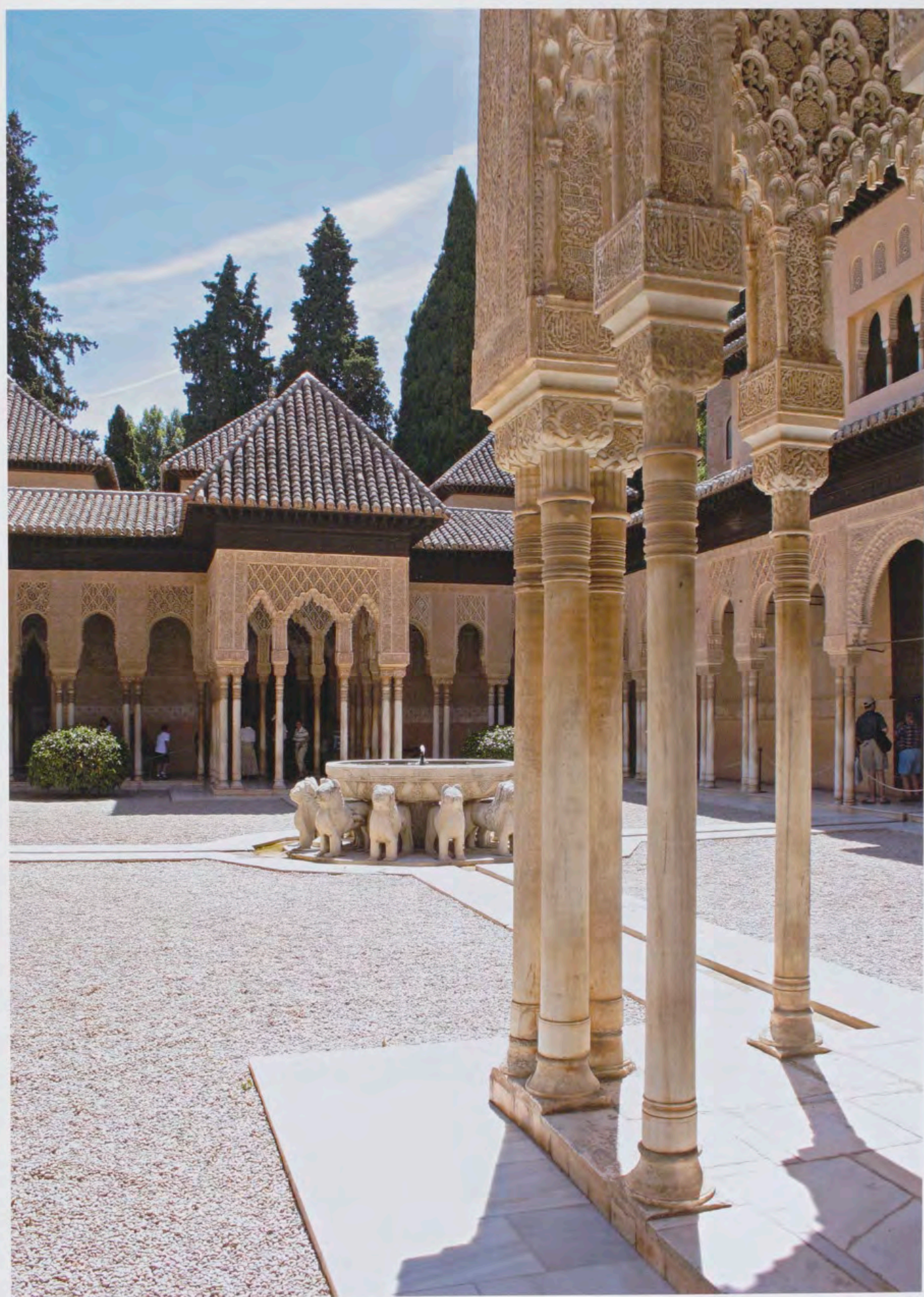
Fig. 6. El Patio de los Leones, Archivo Histórico de la Alhambra, Granada , Fotografía: Alberto Caballero.
