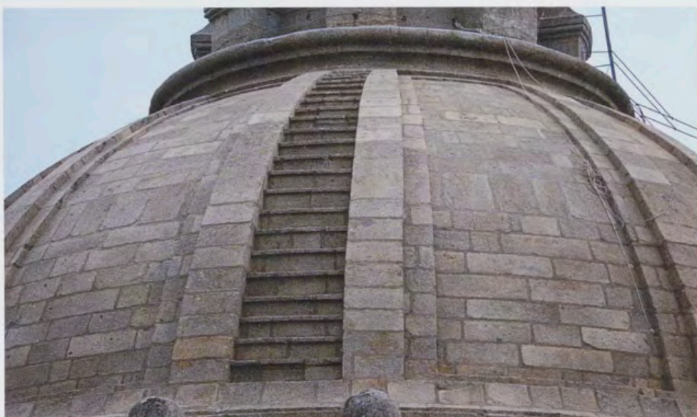
Fig. 14. Detalle del trasdós de la cúpula, Fotografía: Patrimonio Nacional.
