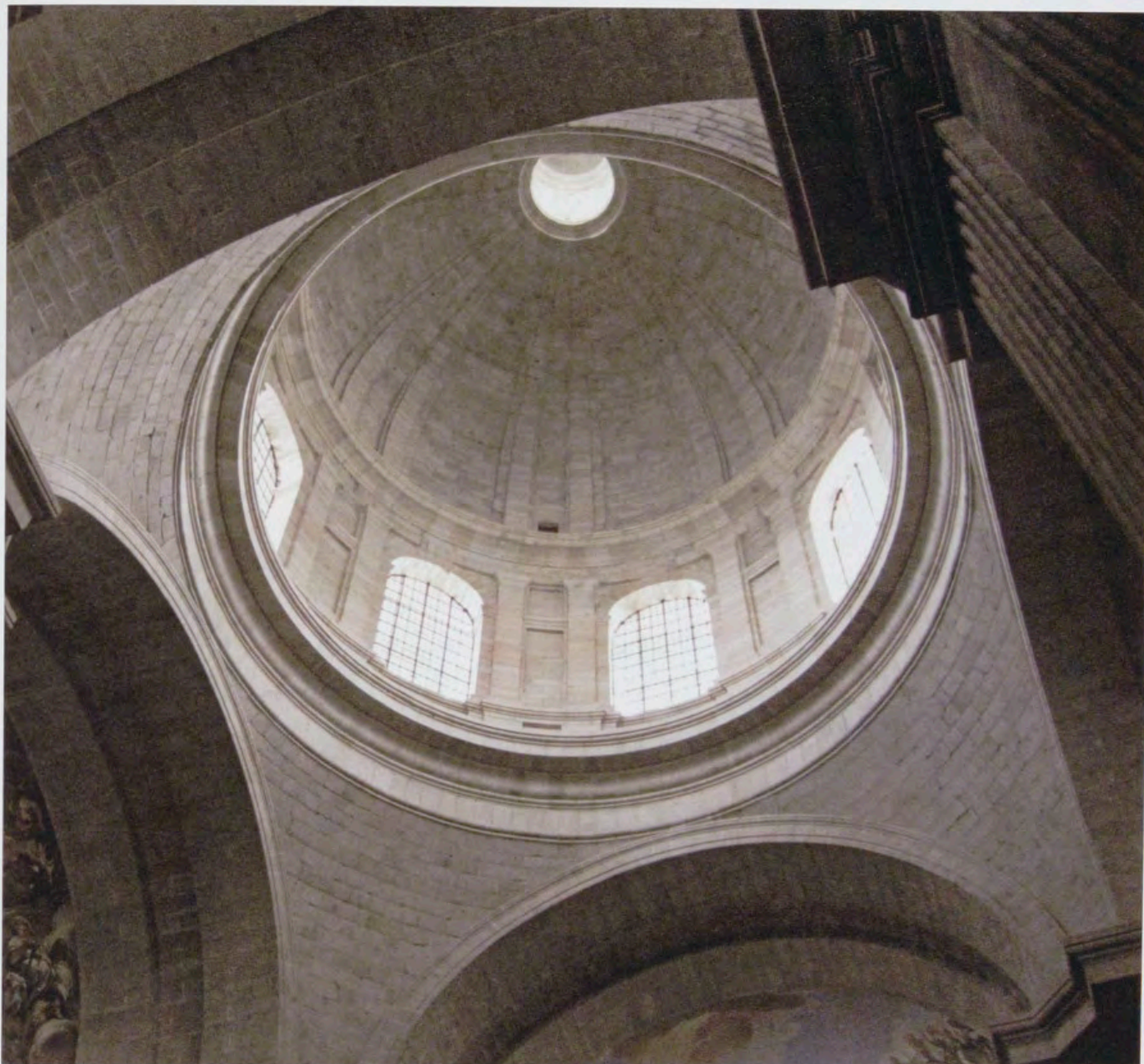
Fig. 3. Vista interior de las pechinas y la cúpula de la Basílica en el momento final de la restauración, junio de 2009, Fotografía: Dirección del Patrimonio Arquitectónico e Inmuebles, Patrimonio Nacional.
