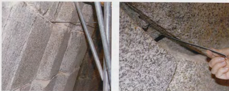
Fig. 16. A la izquierda, disposición horizontal del lecho del grueso de la cúpula entre las hiladas 15 y 16, aunque después cambie la inclinación al asomarse a los resaltos; a la derecha, lecho acodado en el cupulín de la linterna, Fotografía: Patrimonio Nacional.
