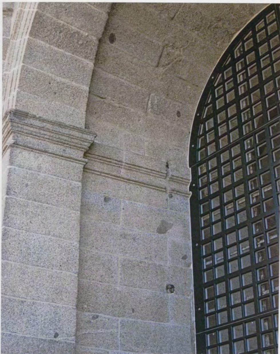
Fig. 11. Carpintería de ventanal del tambor después de la restauración, junio de 2009, Fotografía: Dirección del Patrimonio Arquitectónico e Inmuebles, Patrimonio Nacional.
