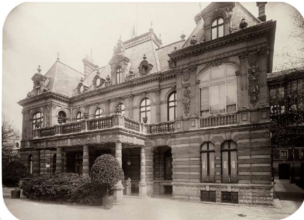
Fig. 8. Fachada principal del palacio de Castilla de París, fotografía de Marius Neyroud, anterior a 1904. AGP, 10189163, Madrid, Patrimonio Nacional.
