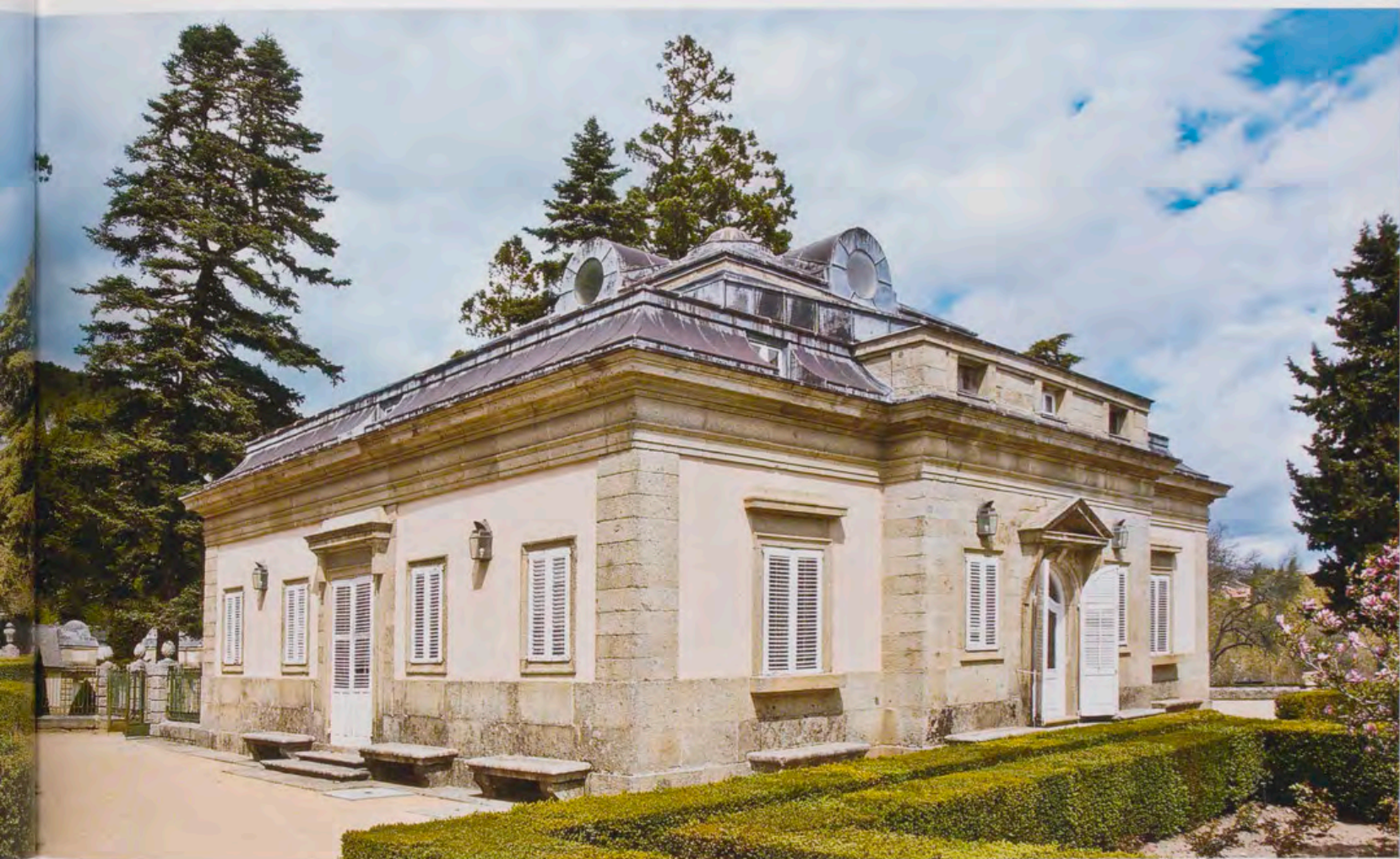
Fig. 12. Vista de la Casa de Arriba desde el jardín, con las fachadas este (o posterior) y sur, estado actual.
